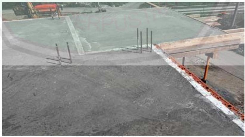
Gambar 2.35 Plat Lantai Beton
