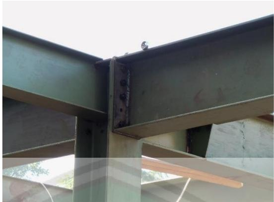
Gambar 2.33 Balok Baja Pada Bangunan Proyek
