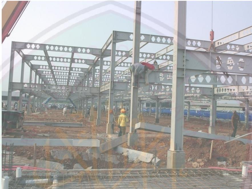
Gambar 2.31 Contoh Kolom Baja Pada Bangunan Proyek
