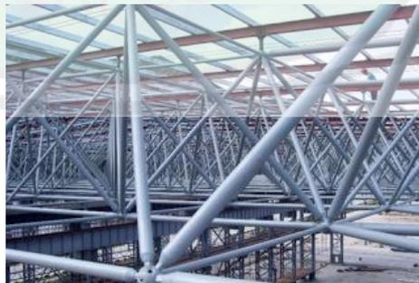
*Gambar 2.9 Bentuk Space Frame Sebagai Struktur Atap
